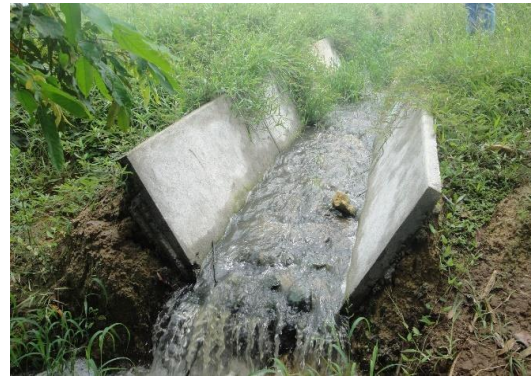
Canalización aguas residuales San Antero, departamento de Córdoba.
